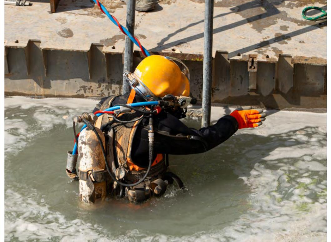
Aufgrund des hohen Grundwasserstands wurde die Betonsohle im August 2025 unter Wasser mit der Hilfe von Berufstauchern hergestellt.
