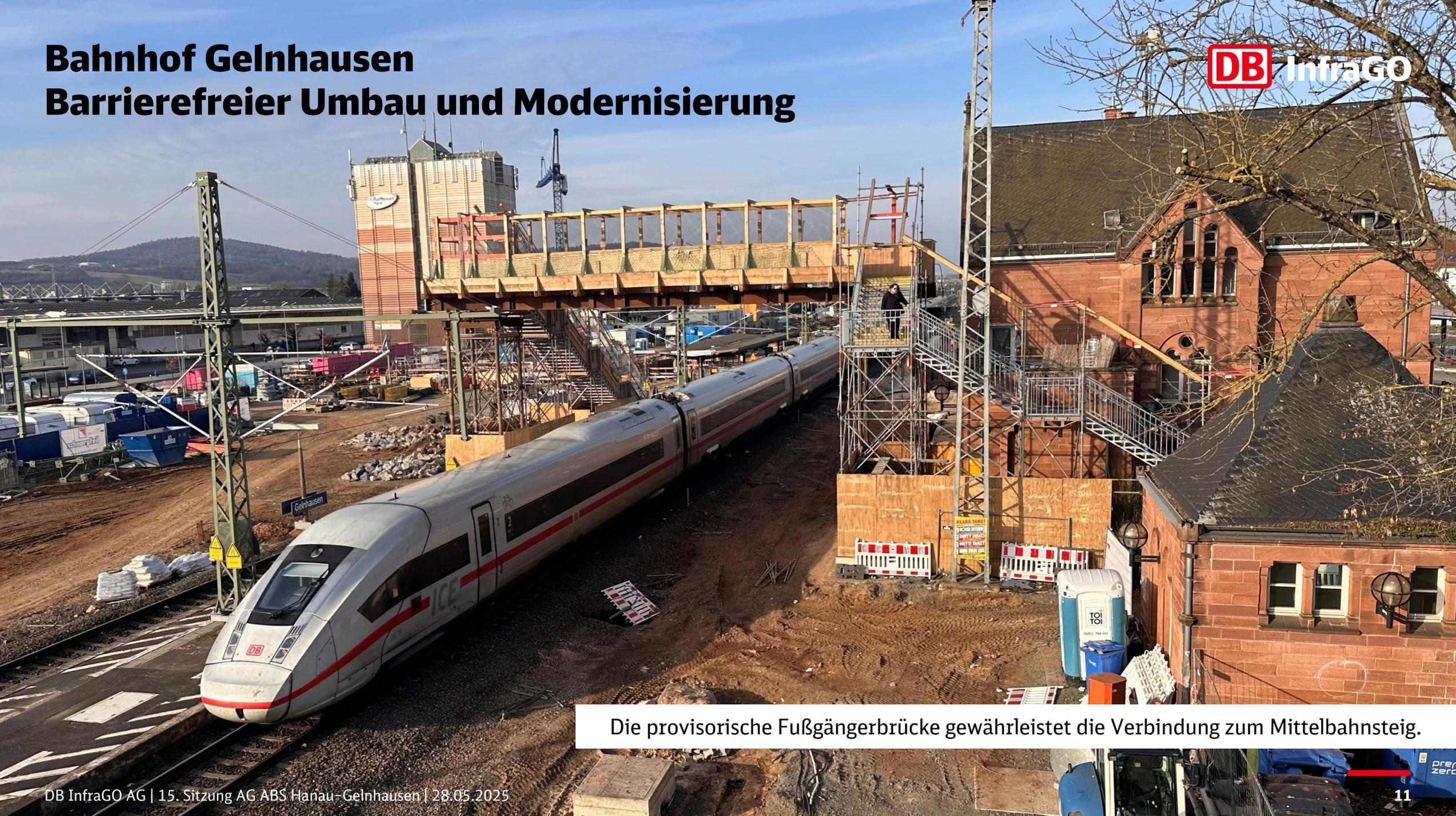
Die provisorische Fußgängerbrücke gewährleistet die Verbindung zum Mittelbahnsteig.
