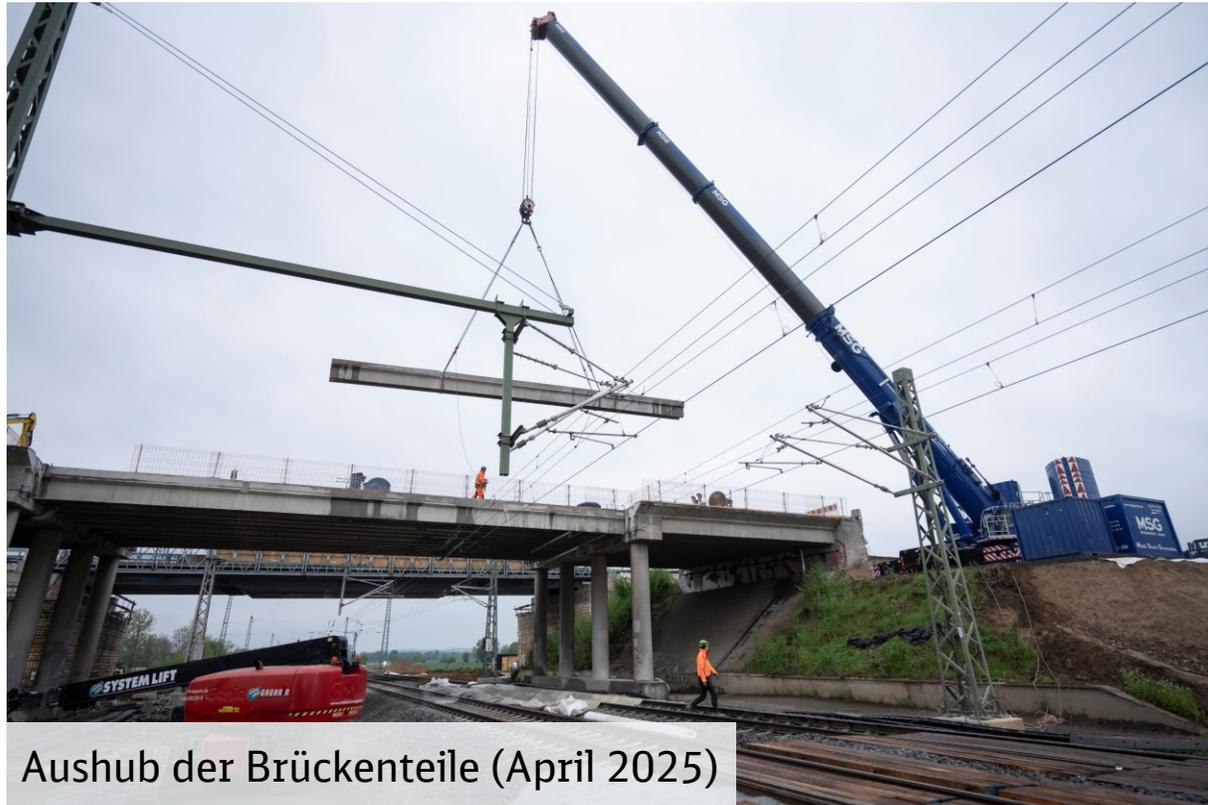
Aushub der Brückenteile (April 2025)
